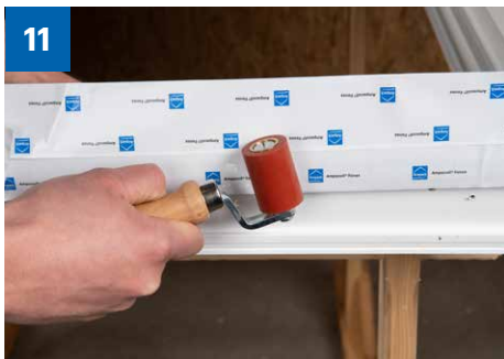
11 > Fensterschürze umlaufend gut anrollen.
