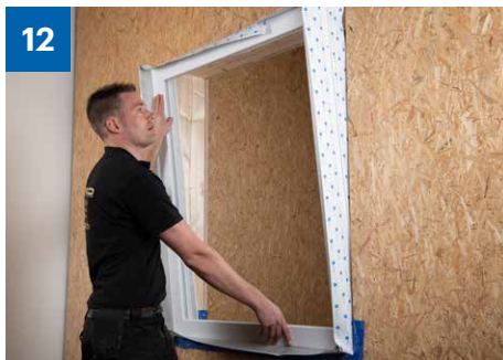
12 > Fensterrahmen fachgerecht in Wandöffnung montieren.
