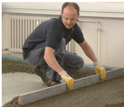
Verlegung des Leichtausgleichsmörtels UZIN SC 914 Turbo
