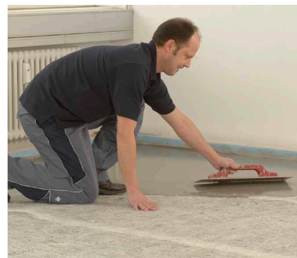
Auftrag der Fliesenspachtelmasse codex FM 50 Turbo
