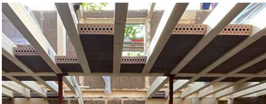
Montage/Einbau vom Lehm-Deckenstein in ein Strohballenhaus
