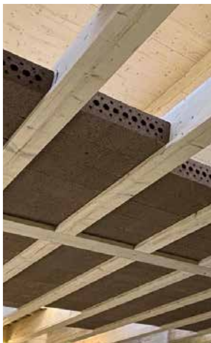
Montage/Einbau vom Lehm-Deckenstein in ein Strohballenhaus
