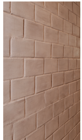
Sichtmauerwerk mit glatten Lehmsteinen, geschlämmt
