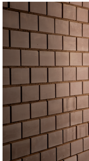
Sichtmauerwerk mit glatten Lehmsteinen
