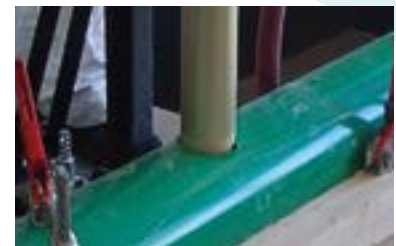
Trockenbohren in Kunststoff
