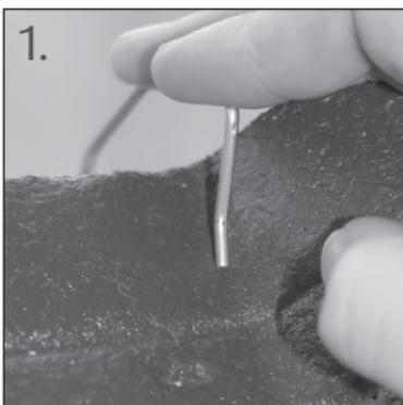
Bei Lattung 40 x 60 mm Klammerkopf von vorne über den Pfannenkopf setzen ...
