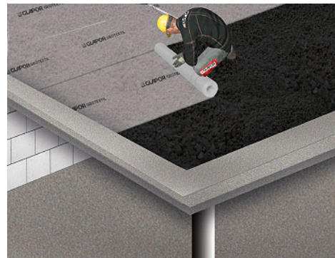
Trennlage mit Überdeckung verlegen
