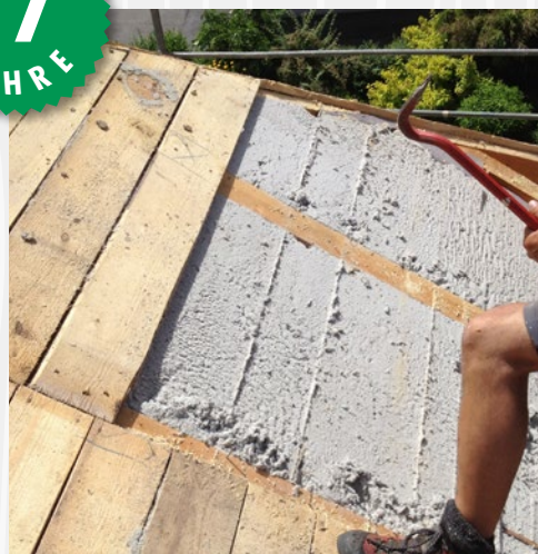
Nach 17 Jahren geöffneter Dachstuhl (EFH Tirol). Die ISOCELL Zellulose wirkt wie frisch eingeblasen.
