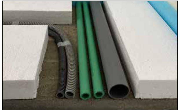
Installationsebene mit Dämmplatten des Anwendungstyps DEO auslegen
