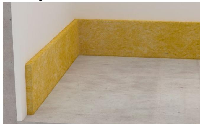
Fertighöhe des Estrichs an allen aufgehenden Bauteilen markieren und GIFAfloor Randdämmstreifen MW mit Oberkante mindestens 5 mm höher als Fertighöhe fixieren.
