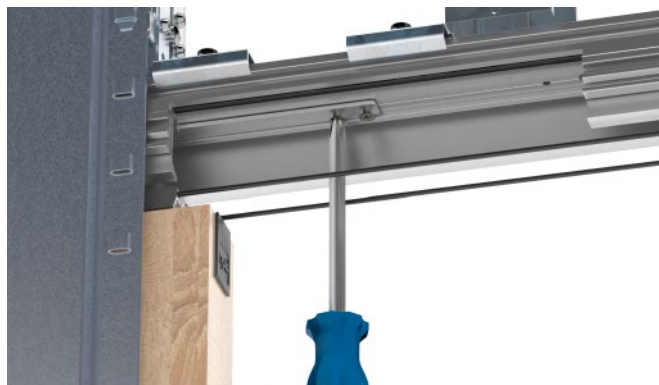
Bild 34: Feststelllasche verschrauben
