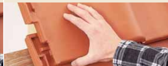
Ziegel im Fußbereich andrücken. Fertig!
