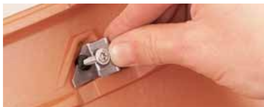
SturmFIX in die Vertiefung des Ziegels einsetzen.
