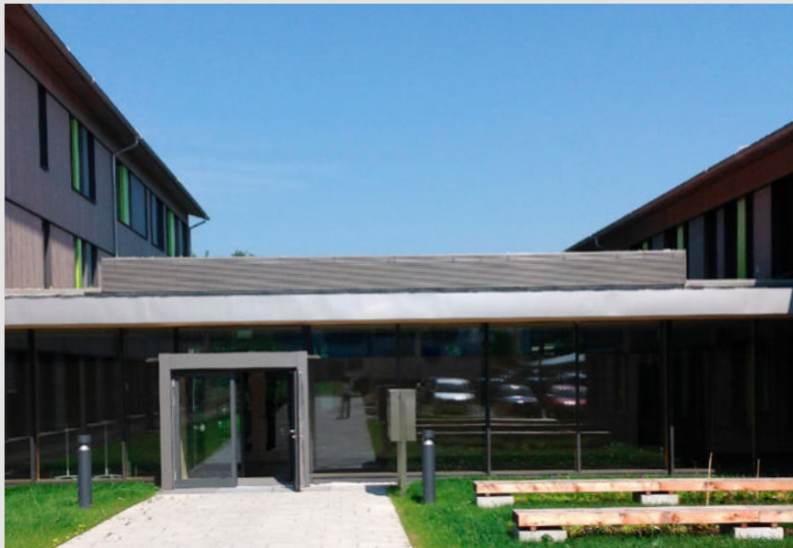
Gefälledach mit Außenentwässerung, Grünes Zentrum Holzkirchen
