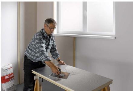
LINITHERM PAL SIL mit üblichen Holzbearbeitungsmaschinen zuschneiden, Kleber vollflächig bzw. bei unebenem Untergrund punktuell und mit Randwulst aufbringen.
