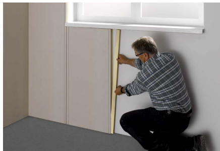
Platte im Endlosverfahren stoßversetzt direkt auf das Mauerwerk oder den tragfähigen Putz aufkleben, dabei Kreuzfugen vermeiden.
