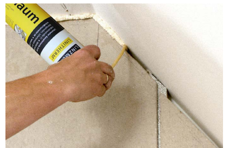
... Hohlräume der Anschlussfugen ausschäumen und Plattenstöße mit Einbettung von einem Papierfugendeckstreifen verspachteln.
