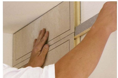
Quer- und Längsstoß mit Feder versehen ...
