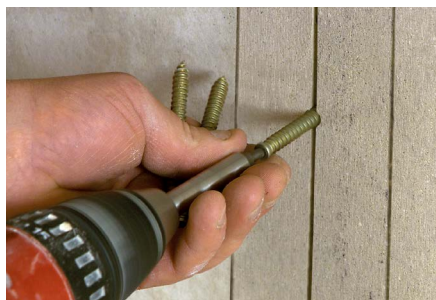
Im Bereich der Feder mit versenkbaren Rahmenschrauben mechanisch sichern ...
