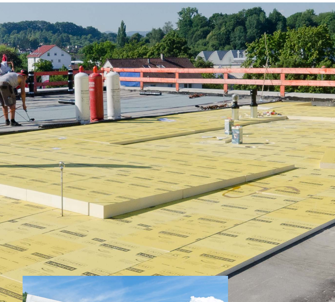
LINITHERM PGV Gefälledämmung Feuerwehrhaus Wannweil
