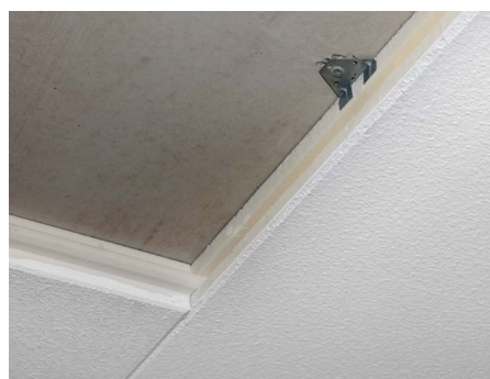
Kellerdeckendämmung unter Betondecke
