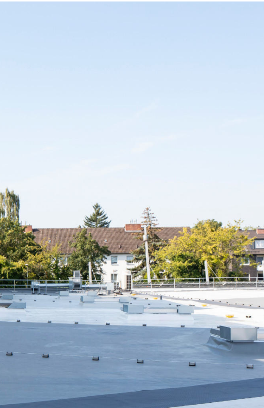
LINITHERM LOOP Gefälledämmung mit Gratplatten von 130 mm bis 30 mm, für besseren U-Wert mit vollflächiger Unterlage bei Rinnenentwässerung
