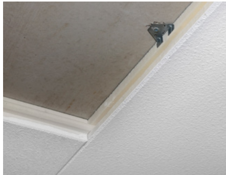
Kellerdeckendämmung unter Betondecke
