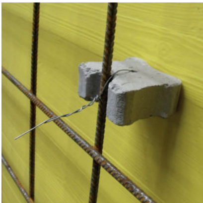
Einzelabstandhalter „Knochen mit Draht“
