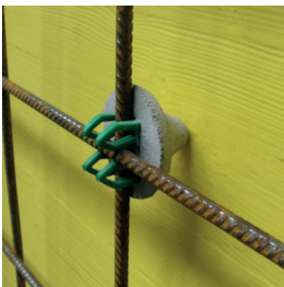
Gießbetonabstandhalter „runde Auflage“
