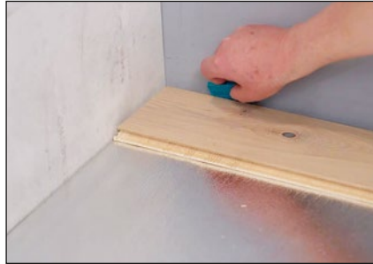
Verlegefläche ausmitteln/auswinkeln und die erste Dielenreihe durch Zuschneiden anpassen.
