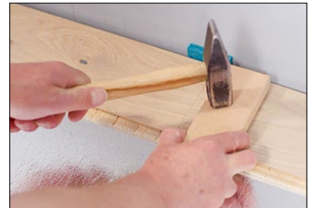
Fügen Sie die Kopffugen mit einem Hammer und Schlagschutz zusammen. Die Längsund Kopffugen verriegeln dabei automatisch. Diese Verlegung im ganzen Raum fortsetzen.
