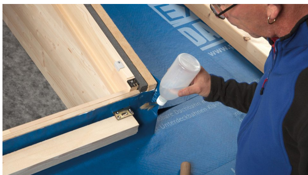
9. Zuvor gefaltete Ecke verschweißen.
