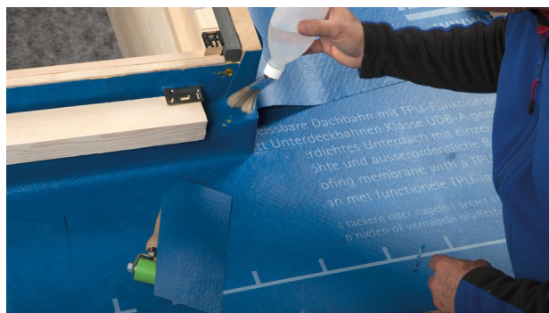
12. Passtück im Eckbereich an die Unterkante des Fensterrahmens/ Dämmrahmens aufschweißen.
