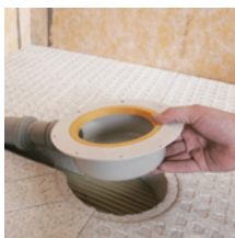
zu 3.: Ablaufgehäuse einsetzen
