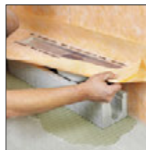
zu 2. Rinnenkörper einsetzen
