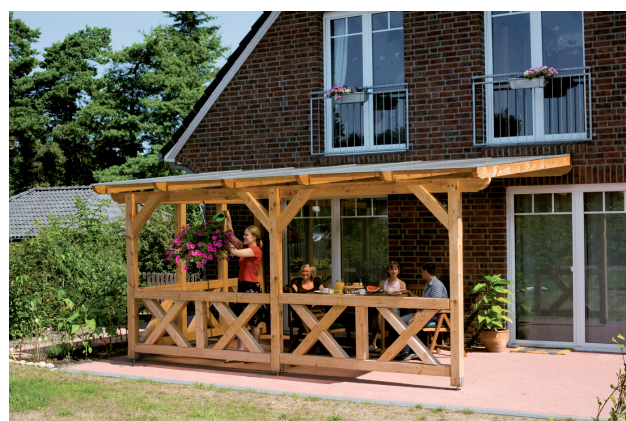
Kundenfoto: Terrassenüberdachung mit Brüstungen und Seitenwand
