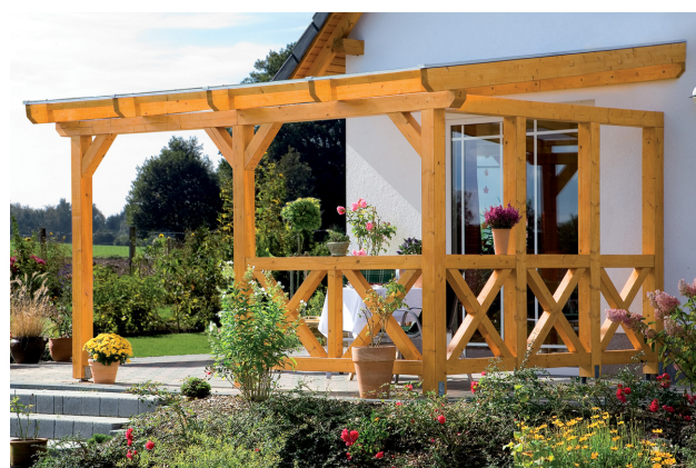
Kundenfoto: Terrassenüberdachung mit einer Brüstung und Seitenwand
