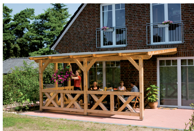
Kundenfoto: Terrassenüberdachung mit Brüstungen und Seitenwand
