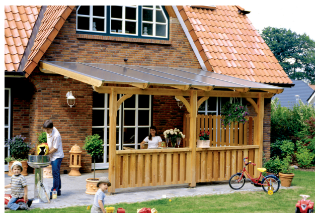
Kundenfoto: Terrassenüberdachung mit Brüstungen und Seitenwand
