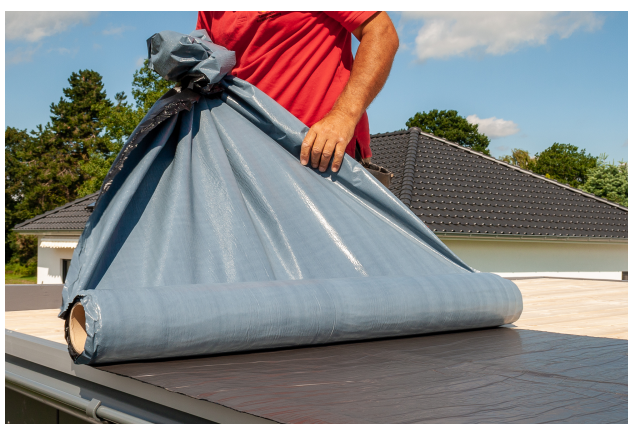
KSK-M Dachbahn beim verlegen
