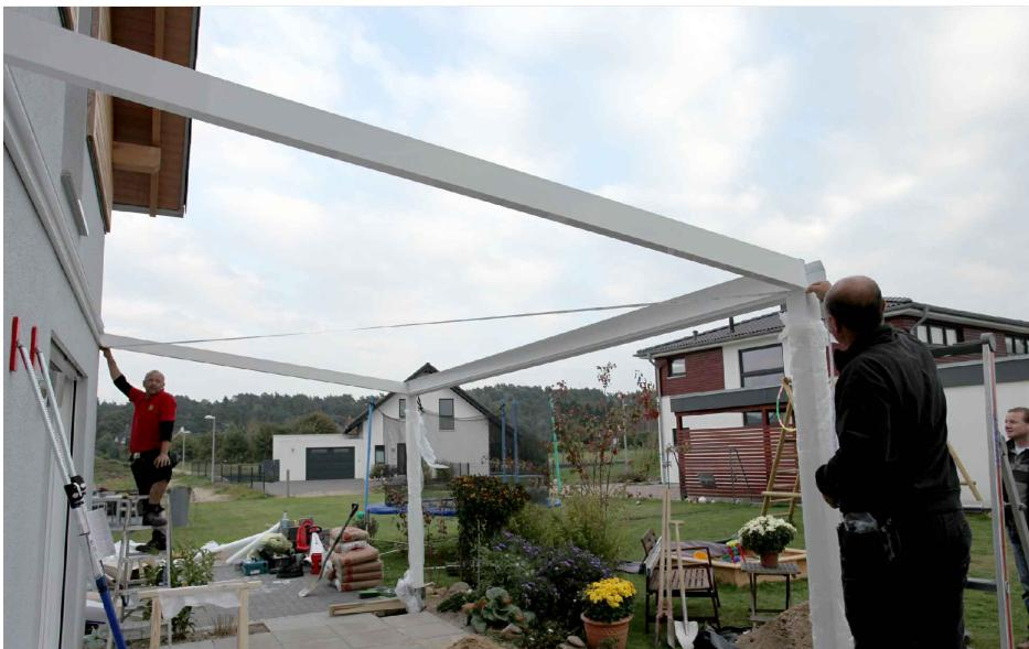
Richten Sie die Konstruktion mit einem Maßband über die Diagonale aus.
