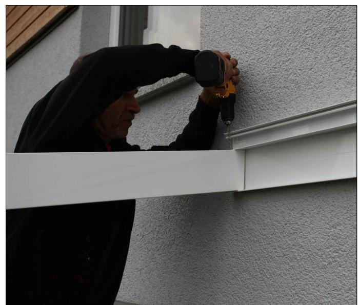
Bohren Sie die Schraublöcher mit einem 4mm Metallbohrer vor und verschrauben Sie die Sparren mit jeweils einer Karosserieschraube (C101-025) an den beiden Pfetten.
