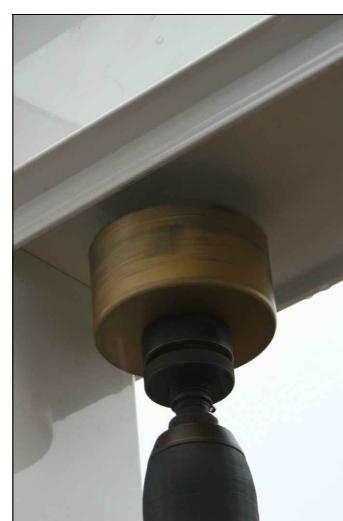
Mit einer Bohrkrone (Durchmesser 68-70mm) bohren Sie jetzt den Anschluß für das Fallrohr. Es kann sowohl neben als auch im Pfosten verbaut werden. Bitte beachten Sie dabei den Versatz in der Rinnenpfette (siehe Detailzeichnung) sowie den Abstand der Clipphalter für das Fallrohr zum Pfosten! (ca. 2cm)
