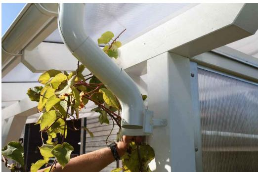
Schneiden Sie nun den Rohrverbinder (C167-01/02) auf die benötigte Länge zu. Achten Sie darauf, dass Rohr und Rohrbogen (C166-01/02) ausreichend weit ineinander stecken.
