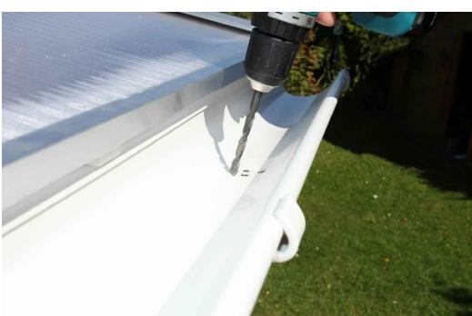
Bohren Sie an dem gewünschten Ende der Halbrundrinne (C160-Längen) ca. 15 Löcher ( $\varnothing$  9 mm) für den Wasserablauf. Anschließend legen Sie die Halbrundrinnen zusammen mit dem Rinnenablaufstutzen (C164-01/02) in die Rinnenhalter. Nach dem Einhängen müssen ggf. die Radien der Rinnen nachgebogen werden.
