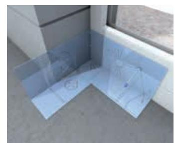
**4.** Bei waagerechten An schlüssen, einfach an den parallelen Aussparungen orientieren. Bei schrägen An schlüssen die Aussparungen entsprechend der Neigung wählen.
