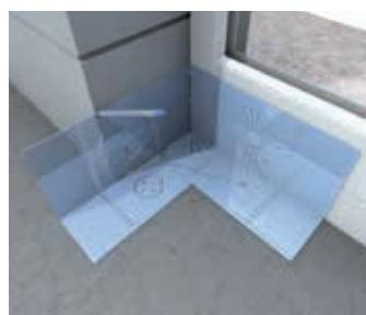
**2.** Einfach die ALSAN Smartform in die entsprechende Ecke knicken und an den Gebäudekanten markieren.
