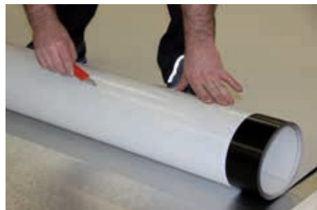
3. Die Folgebahn ausrollen, ausrichten, bis zur Mitte zurückrollen und die unterseitige PE-Folie vorsichtig, ohne Beschädigung der Dachbahn einschneiden.
