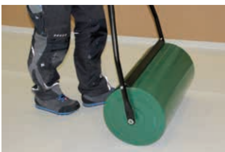
4. Unterseitige PE-Folie abziehen und Bahn ausrollen (Achtung: Nach der Verklebung keine Lagekorrektur mehr möglich!). Anschließend die Bahn mit einer schweren Andruckwalze gleichmäßig anpressen. Die Schritte 3–4 für die zweite Rollenhälfte wiederholen.
