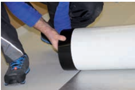
3. Die Folgebahn ausrollen, ausrichten, bis zur Mitte zurückrollen und die unterseitige PE-Folie vorsichtig, ohne Beschädigung der Dachbahn einschneiden.
