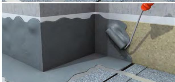
3. Nach der Durchtrocknungszeit der Grundierung wir die Einbettsschicht auftragen. Vor allem bei Materialübergängen, im Eckbereich oder bei vertikalen Flächen ausreichend Material vorlegen (ca. 1,5 kg/m<sup>2</sup>).
