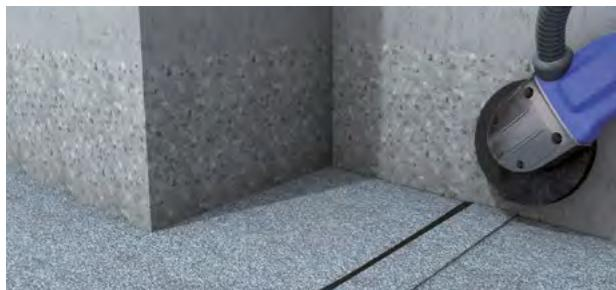
1. Vor Beginn der Abdichtungsarbeiten mineralische Anschlussbereiche anschleifen. Lose Schieferschuppen der Bitumenbahn mittels Drahtbürste entfernen. Mit PE-beschichtetem Abdeckband abkleben.
