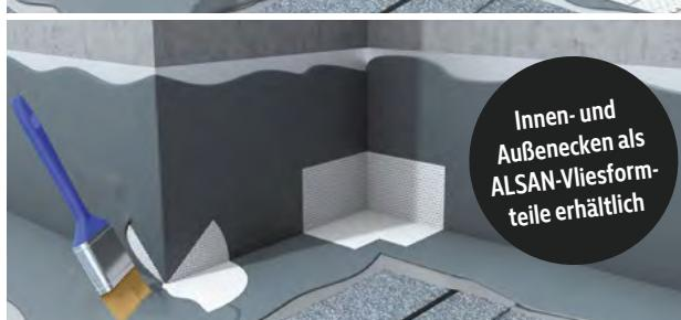
5. Ohne Wartezeit kann dann direkt das Vlies mit einer weiteren Schicht überdeckt werden.
