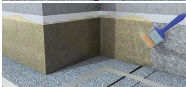
2. Fläche im Bedarfsfall gemäß Untergrundtabelle grundieren. Beschieferte Bahnen müssen nicht grundiert werden. Grundierung mittels Roller oder Pinsel auftragen.
