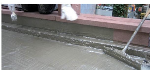
3. Mittels Gummischeiber SOPRAVAP 3/1 gleichmäßig verteilen.
