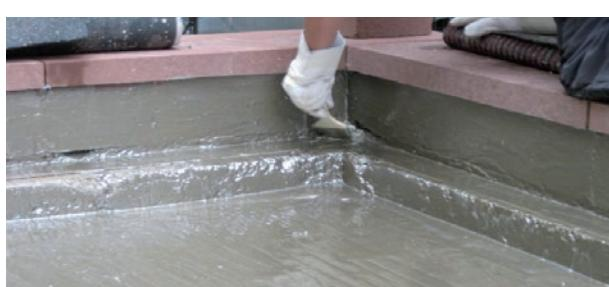
4. An den aufgehenden Bauteilen SOPRAVAP 3/1 entsprechend der Dicke der Wärmedämmung hochführen.
