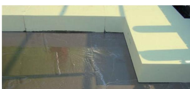
5. Nach Applizierung der Fläche mit SOPRAVAP 3/1 sofort die Wärmedämmung verlegen.
