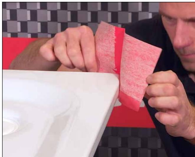
3 Nach dem Abziehen der Schutzfolie vom Klebestreifen die Sopro WannenDichtEcke am Wannenrand ausrichten, ankleben und festdrücken. Das hochflexible Formteil ist für alle gängigen Wannenradien geeignet.
