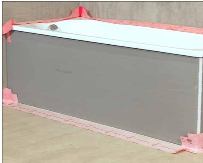
7 Im Bereich vor und über der Wanne sind Sopro AEB® Flex Dichtband sowie AEB® Dichtecken zu verwenden. Alle waagerechten und senkrechten Bänder auf die richtige Länge zurecht schneiden (mind. 50 mm Überlappung)
