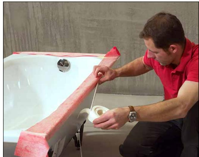
6 Bänder und Formteile mit Kreppband provisorisch an der Wanne fixieren. Dann den selbstklebenden Sopro WannenDichtSchallschutz ankleben und festdrücken. Wanne danach an der Wand ausrichten und anschließen.
