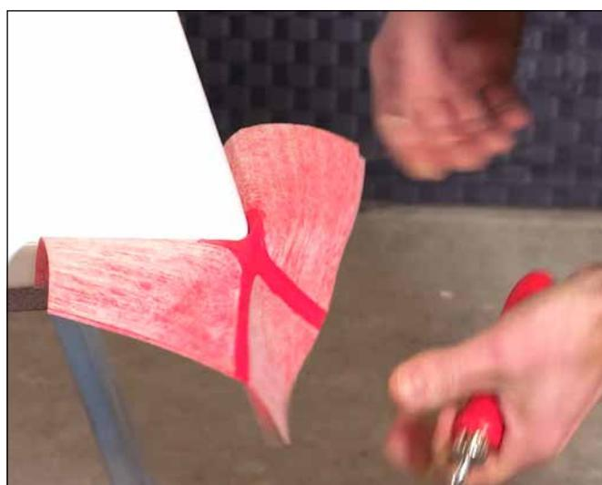
5 Treffen Duschwanne und Wand in einer Flucht aufeinander, werden zwei Multiecken an gleicher Stelle übereinander geklebt. Mit Hilfe eines Rollers können die Multiecken fest angedrückt werden.
