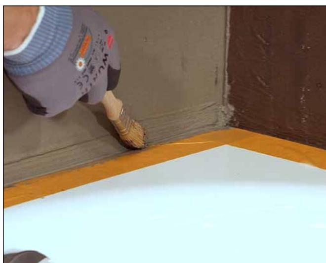
11 Alle Übergänge der Bänder und Formteile zur Wanne mit einem Pinsel sorgfältig überarbeiten. Bei Bedarf im Bereich von Anschluss und Bewegungsfugen das Sopro SchnittSchutzBand einbetten.
