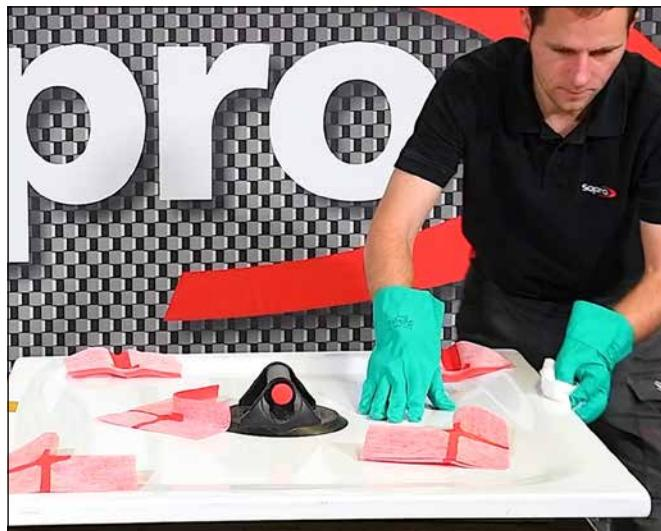
1 Wannenrand mit einem geeigneten Reiniger von Verunreinigungen, Fetten und haftungsmindernden Substanzen befreien. Danach kurz ablüften lassen.
