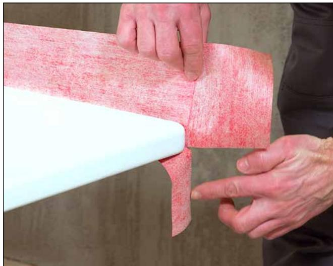
5 Das Sopro WannenDichtBand ist am Wannenende durch das Ankleben eines um 90° gedrehten, ca. 14–16 cm langen, Streifens über den Wannenrand hinaus zu verlängern. Verlängerung im Anschluss einschneiden.
