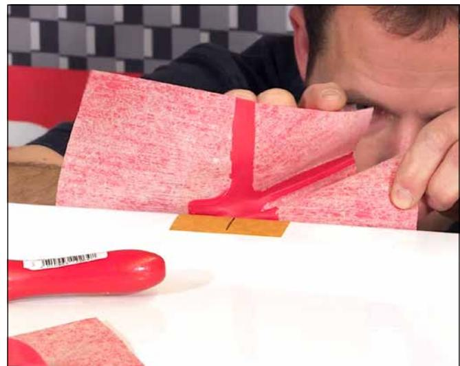
4 Die Sopro WannenDichtMultiecke am Höhe der zuvor angebrachten Markierung ausrichten, ankleben und festdrücken. Das hochflexible Formteil ist für viele verschiedene Einbausituationen geeignet.
