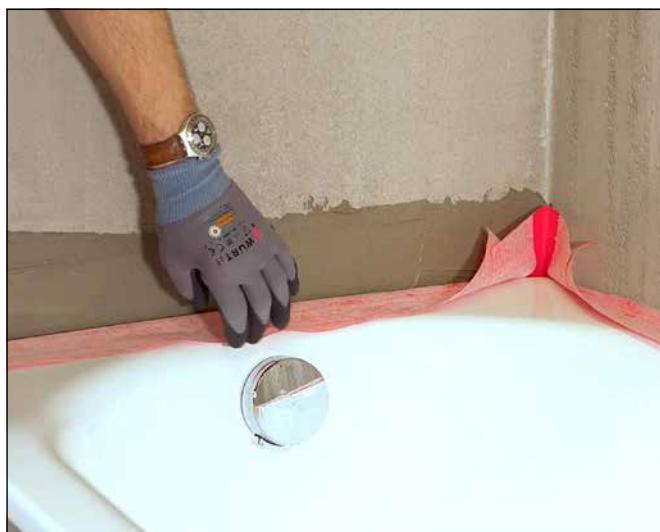
9 Alle Bänder und Formteile in einer Schicht aus Flüssigabdichtung oder Montagekleber vollflächig ankleben. Alle Überlappungen wasserdicht verkleben. Mit Kelle oder Farbrollen-Bügel alle Teile fest andrücken.
