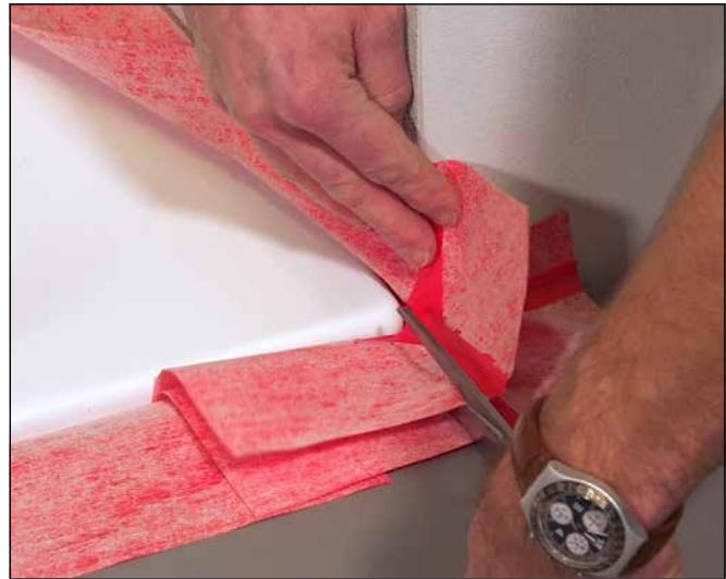
**8** Die beiden übereinander geklebten Multiecken werden eingeschnitten, um diese miteinander einzudichten zu können: Die oben liegende Multiecke auf der linken Seite einschneiden, die unten liegende auf der rechten Seite.
