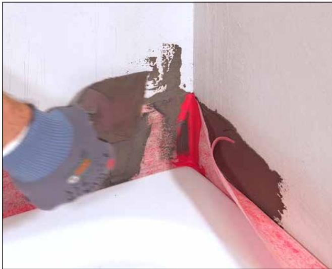
**9** Alle Bänder und Formteile in einer Schicht aus Flüssigabdichtung oder Montagekleber vollflächig ankleben. Mit Kelle oder Farb- rollen-Bügel alle Teile fest andrücken.
