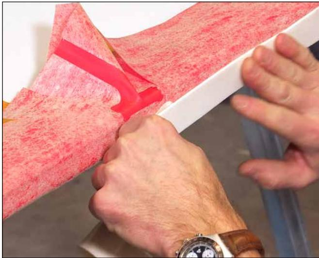
**7** Bänder und Formteile mit Kreppband provisorisch an der Wanne fixieren. Dann den selbstklebenden Sopro WannenDichtSchall- schutz ankleben und festdrücken. Duschwanne danach einsetzen und anschließen.
