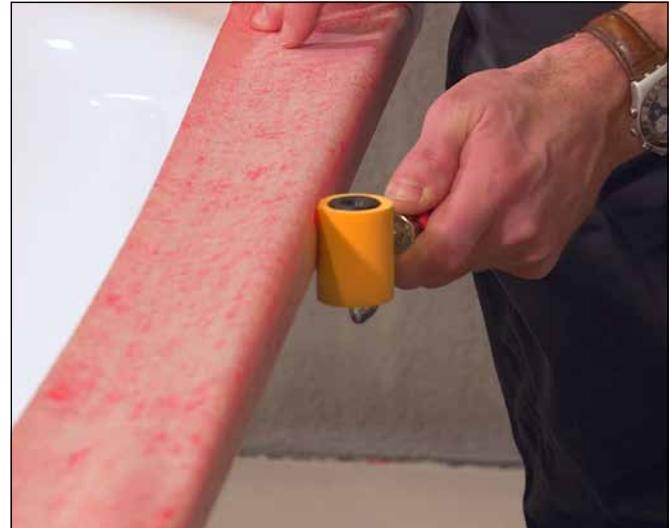
4 Nach dem Abziehen der Schutzfolie vom Klebestreifen das Sopro WannenDichtBand gerade an den Wannenrand ankleben. Mit Hilfe eines Rollers kann das Band im Anschluss fest angedrückt werden.
