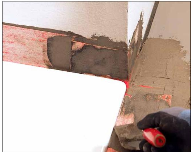
**10** Alle Überlappungen werden wasserdicht miteinander verklebt. Beim Aufbringen der Flächenabdichtung alle Bänder und Formteile vollflächig überarbeiten. Übergänge zur Wanne sorgfältig mit einem Pinsel überarbeiten
