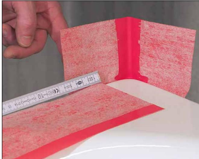
3 Das Sopro WannenDichtBand wird auf die Abmessungen der Badewanne zurecht geschnitten. Eine Überlappung der Bänder und Formteile von mindestens 50 mm ist mit einzuberechnen.
