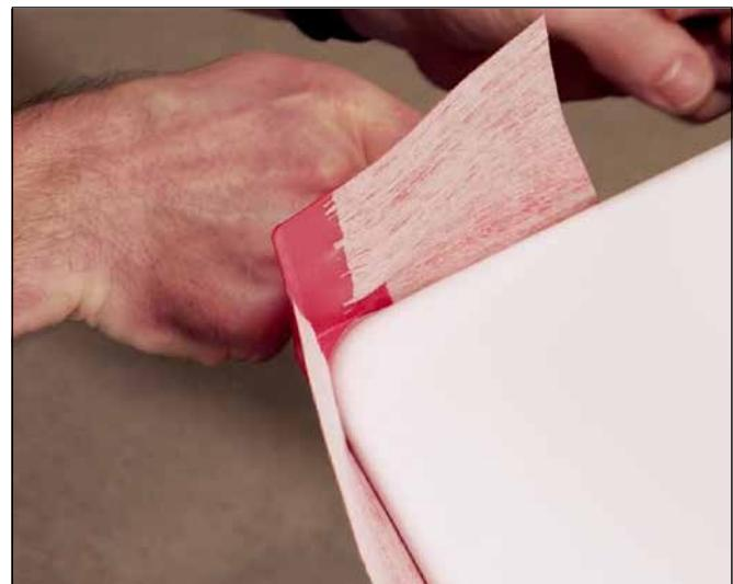
2 Nach dem Abziehen der Schutzfolie vom Klebestreifen die Sopro WannenDichtEcke am Wannenrand ausrichten, ankleben und festdrücken. Das hochflexible Formteil ist für alle gängigen Wannenradien geeignet.
