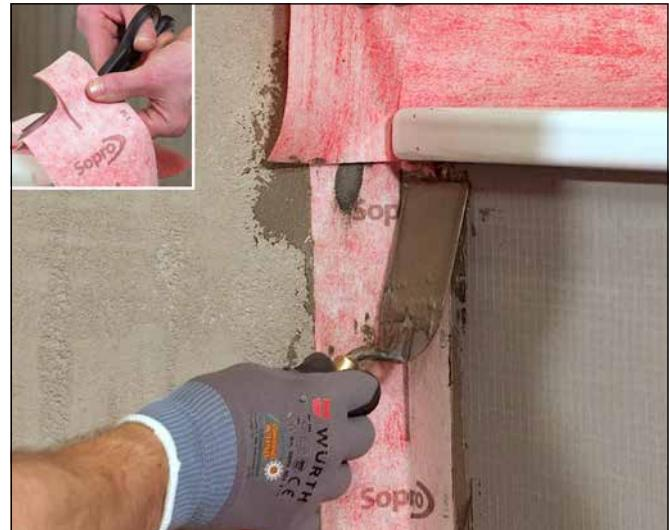
8 Senkrecht vom Boden kommendes Sopro AEB® Flex Dichtband mit einer runden Aussparung am oberen Ende versehen. Dieses an der Wannendichtband-Verlängerung überlappend ansetzen und verkleben.
