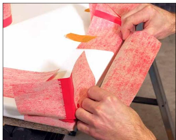
6 Das Sopro WannenDichtBand zurecht schneiden (Überlappung der Bänder und Formteile von mindestens 50 mm beachten). Die Bänder am Wannenrand gerade ankleben und mit einem Roller fest andrücken.
