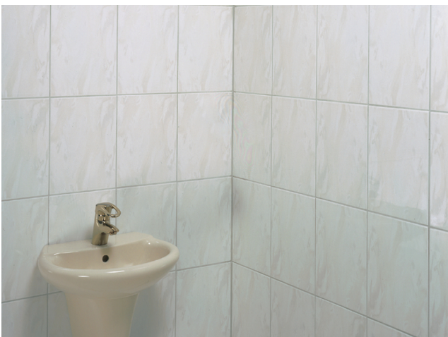
Fertig gefliester und verfugter Wandbereich.
