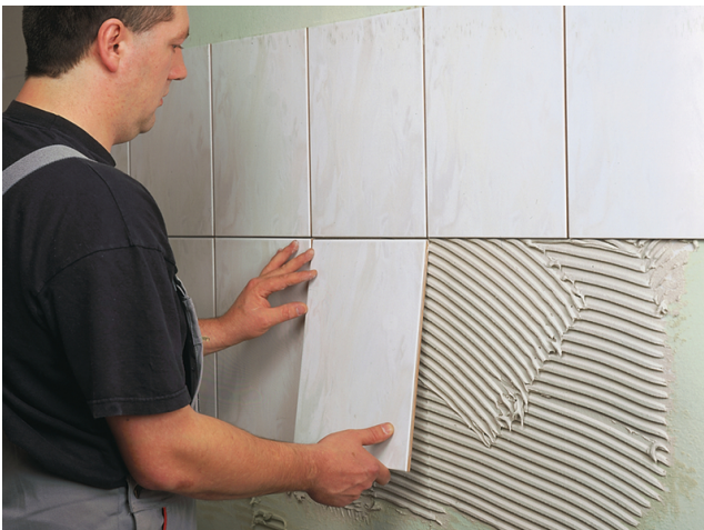
Die Fliesen werden in herkömmlicher Technik mit einem Sopro Fliesen-Kleber angesetzt.
