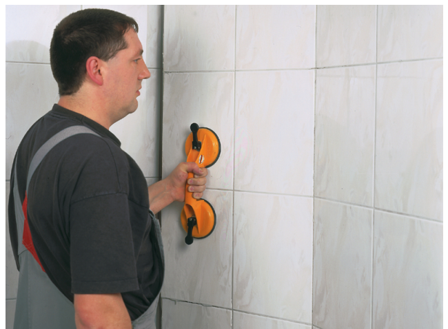
Nach Entfernen der Sanitärobjekte und dem Aufschneiden der Silikonfugen wird der Fliesenbelag mittels eines Sauggriffes aufgenommen.
