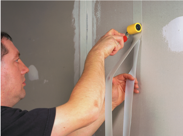
Sopro Fixier-Band wird auf der mit Sopro Grundierung vorbereiteten Fläche angebracht.
