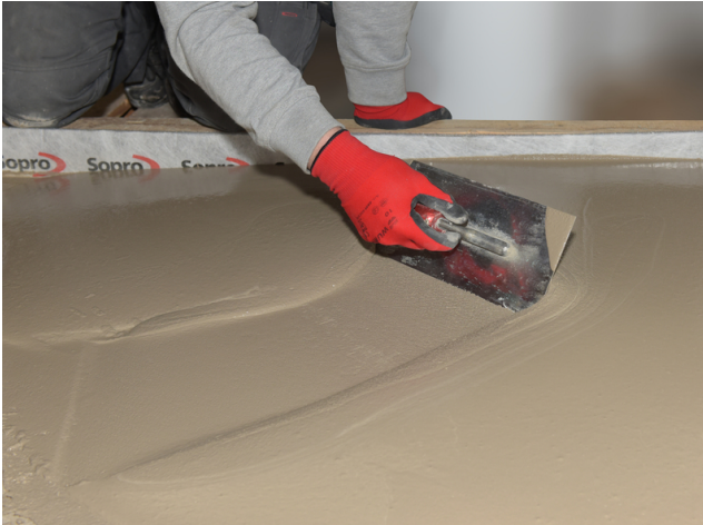
1. Ausbreiten des VS 582 in Gefällekonsistenz bei maximaler Wasserzugabe.
