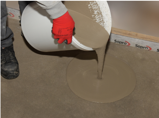
1. Ausgießen des VS 582 in Fließspachtelkonsistenz bei max. Wasserzugabe (5,25 l).
