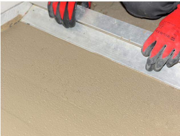
3. Selbstheilungseffekt durch selbstständiges Verdichten des Materials.
