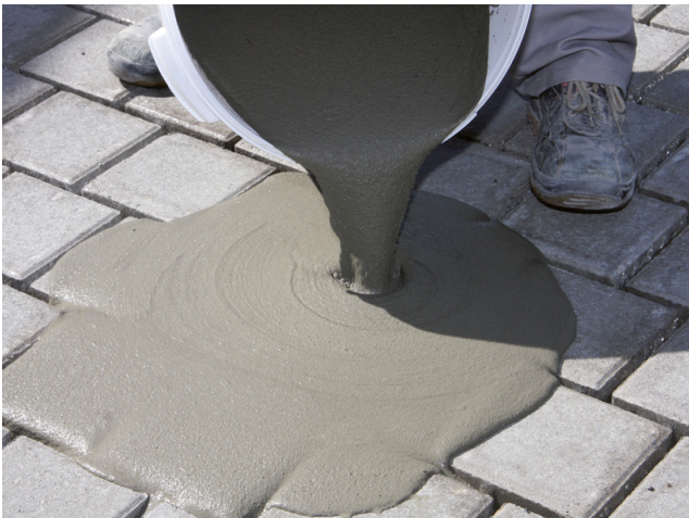
Ausgießen von Sopro BetonSteinFuge.
