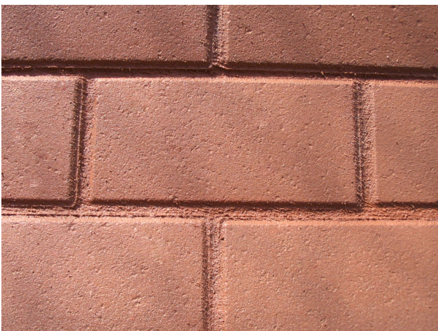
Sauber freigelegte Fuge der Betonpflastersteine mit farblich durch Pigmentzugabe abgestimmter Sopro BetonSteinFuge
