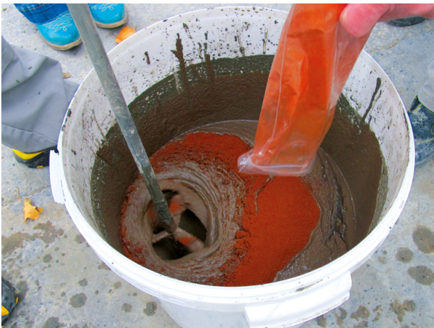
Durch Zugabe von Pigmenten lässt sich die Sopro BetonSteinFuge verschiedenfarbig einstellen.
