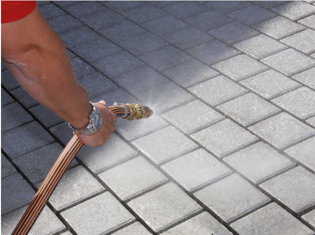
Vornässen des gereinigten, zu verfugenden Belags.
