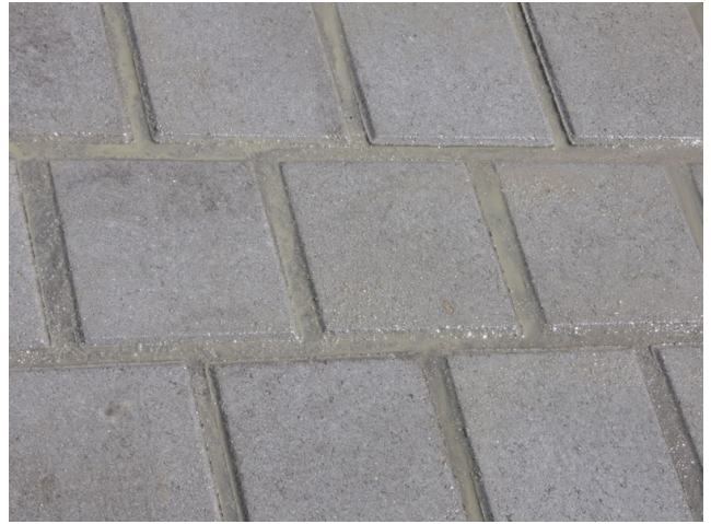
Fertig verfugter Betonsteinpflasterbelag.
