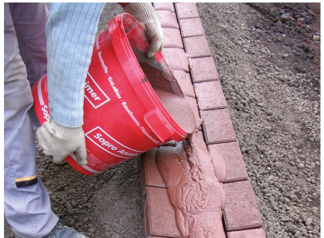
Ausgießen der farblich abgestimmten Sopro BetonSteinFuge.
