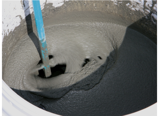
Anmischen von Sopro BetonSteinFuge.
