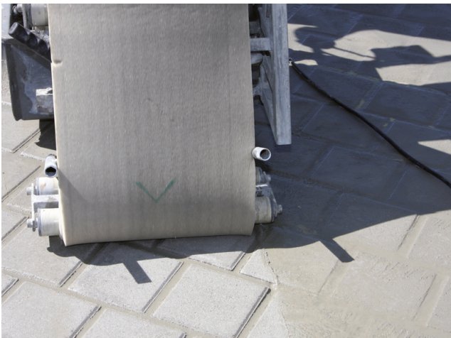
Abwaschen des Belags mit Reinigungsmaschine ...
