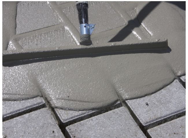
Fugenfüllendes Einbringen von Sopro BetonSteinFuge.
