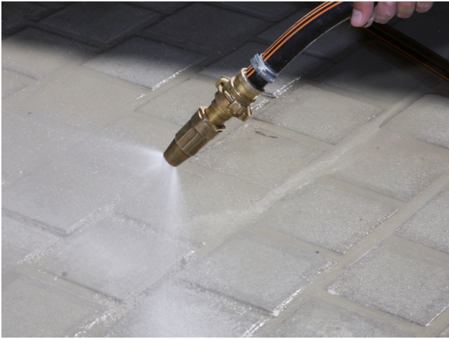
Absprühen mit feinem Wasserschlauch nach Erstarrungsbeginn des Fugenmörtels.
