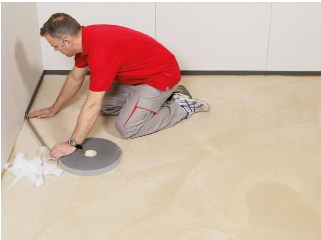
Um Schallbrücken zu vermeiden, sind vor Beginn der Fliesenverlegearbeiten Randdämmstreifen (z. B. Sopro RandDämmStreifen) je nach Belagsstärke anzubringen.
