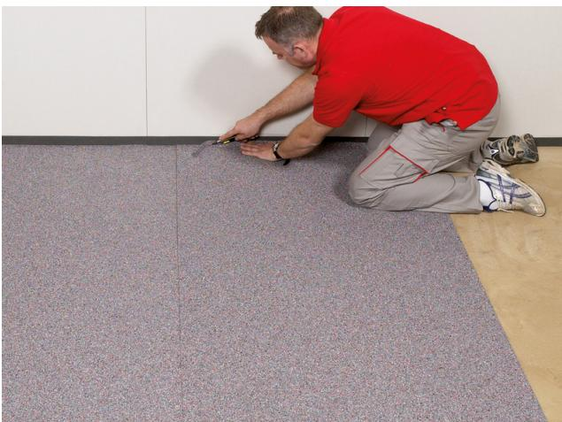
Die Bahnen vor der Verlegung etwas größer zuschneiden, vollflächig lose auslegen ...
