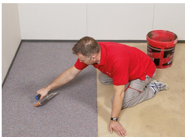
Die einzelne Bahn faltenfrei in das Mörtelbett einlegen und mit der glatten Seite der Zahnkelle andrücken und abstreichen, sodass keine Lufteinschlüsse unter der Bahn verbleiben.
