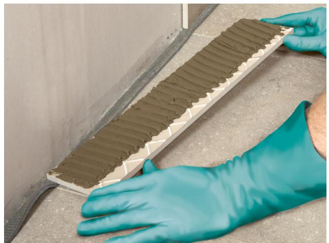
Die Sockelfliesen werden mit rückseitig aufgetragenem Verlegemörtel verklebt. Der Randdämmstreifen muss zwischen Sockelfliese und Bodenfliese herausschauen...
