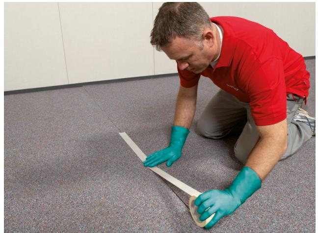
Zur Vermeidung von Mörtelbrücken (Körperschallbrücken) können die Stöße der Bahnen mit Klebeband überklebt werden.
