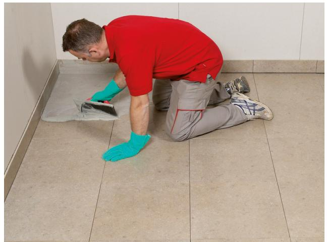
Nach Erreichen der Begeh- und Verfugbarkeit wird der keramische Fliesenbelag mit z. B. Sopro DF 10® Design-Fuge Flex verfugt.
