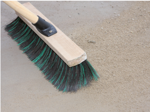
Säubern des vorbereiteten, ebenmäßigen Untergrundes.
