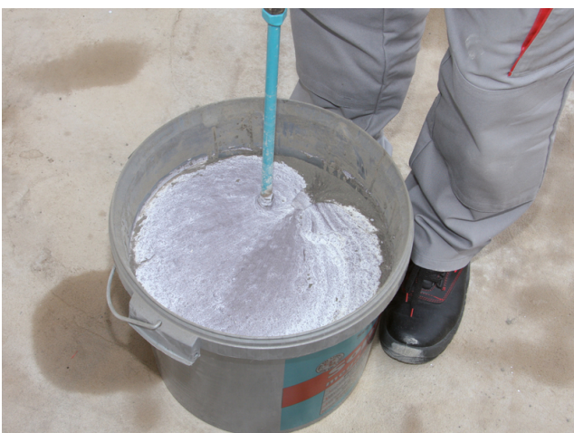
Homogenes Anmischen der zwei Komponenten ...
