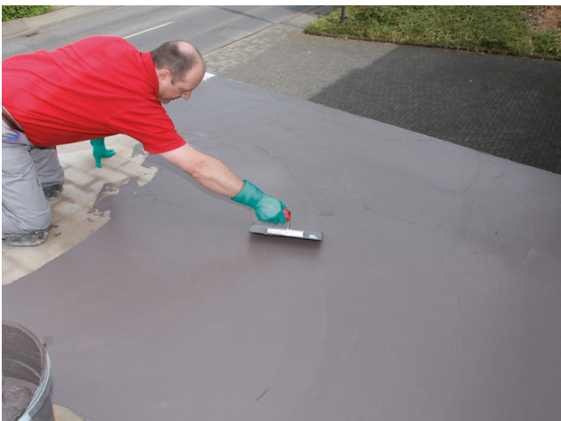
Glätten der Sopro TurboDichtSchlämme 2-K mittels Glättkelle.
