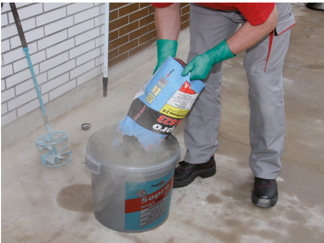
Hinzugeben der Trockenkomponente der Sopro TurboDichtSchlämme 2-K.
