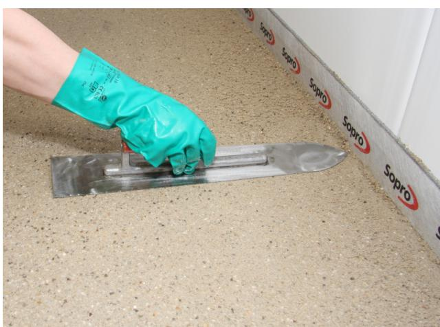
Durch Verdichten und Glätten mit dem Estrichschwert wird eine homogene, ebene Oberfläche erzielt.
