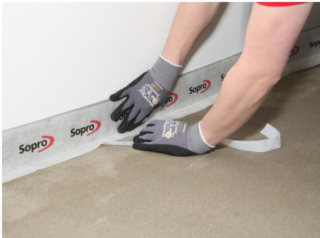
Im Anschlussbereich von Wand und Boden den selbstklebenden Sopro EstrichRanddämmStreifen stellen.
