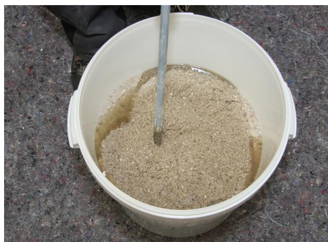
Sopro EpoxiEstrichKorn und Sopro BauHarz mit geeignetem Rührquirl zu einem klumpenfreien, homogenen Mörtel mischen.
