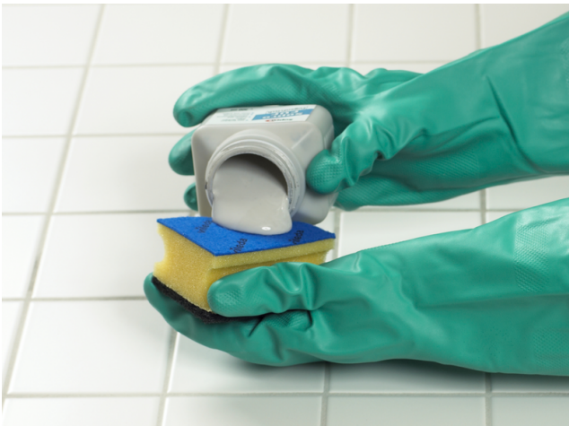
3 Nach dem Abtrocknen von Fliese und Fuge ist Sopro FugenFrisch auf einen Schwamm oder einem Pinsel aufzutragen.
