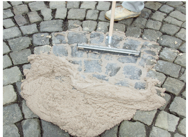
Gut verdichtendes Einbringen von Sopro HF® EpoxiPflasterFuge.
