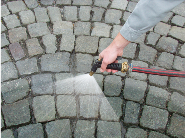
Vornässen des gereinigten, zu verfugenden Belags.
