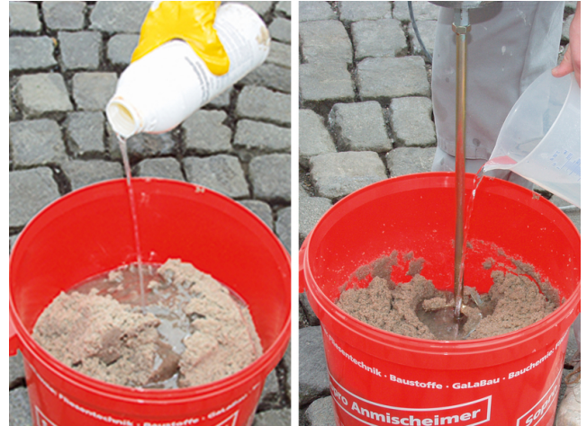
Härterzugabe und Anrühren von Sopro HF® EpoxiPflasterFuge. Nach dem Anrühren maximal 2 l Wasser zugeben und erneut anrühren.
