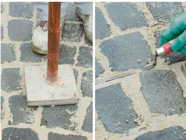
Intensives Verdichten von Sopro HF® EpoxiPflasterFuge mit Stampfer bzw. Fugeisen.
