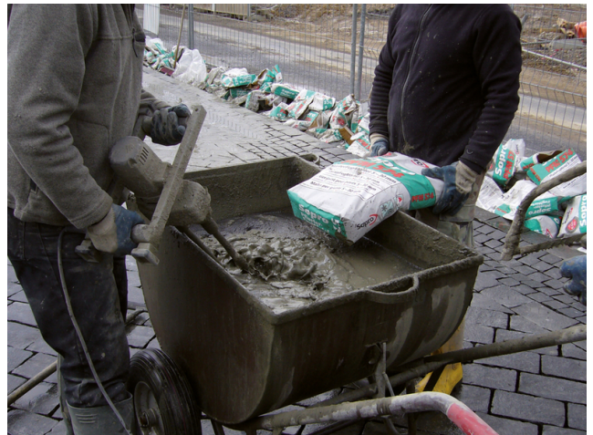
Alternativ: Anmischen des Fugenmörtels mittels Rührgerät.
