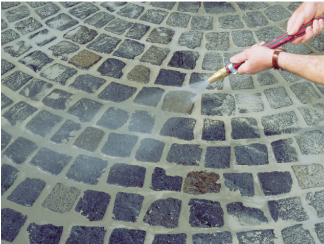
Absprühen mit feinem Wasserschlauchstrahl nach Erstarrungsbeginn des Fugenmörtels
