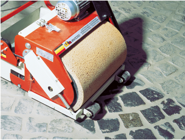
Abwaschen des Belags mit Reinigungsmaschine ...
