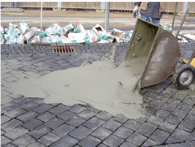
Leichtes Verfüllen der Fugen aufgrund hervorragender Verlaufeigenschaften des Fugenmörtels.
