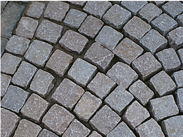
Naturwerksteinpflaster mit unterschiedlichen Fugenbreiten, bedenkenlos verfüllbar mit Sopro PflasterFugMörtel hochfest.
