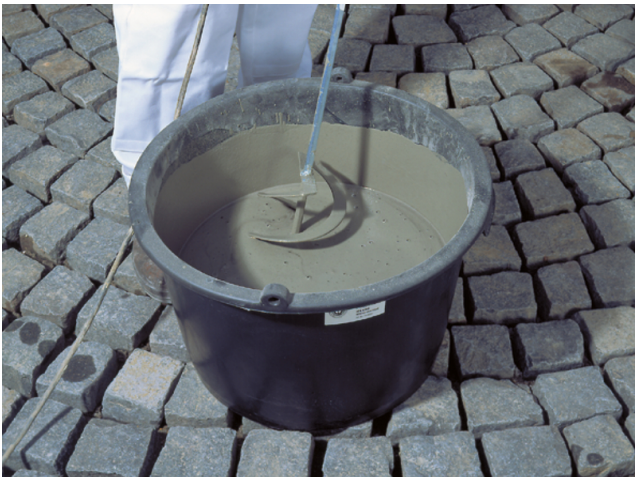
Anmischen von Sopro PflasterFugMörtel hochfest mit Wendelkorbrührer.
