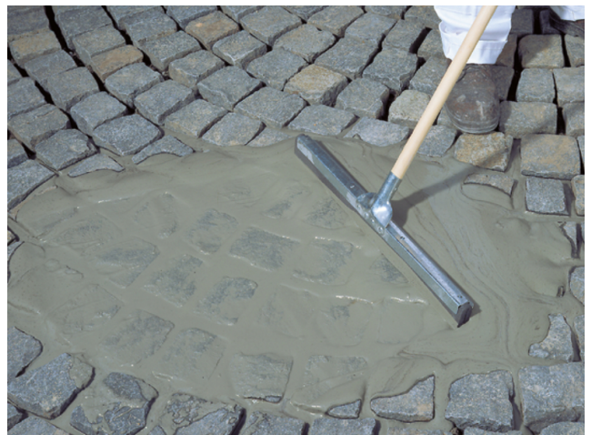
Fugenfüllendes Einschlämmen von Sopro PflasterFugMörtel hochfest.
