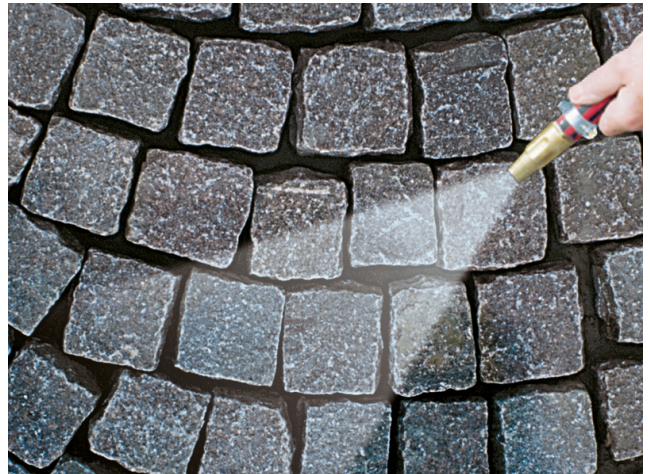
Vornässen des gereinigten, zu verfugenden Belags.
