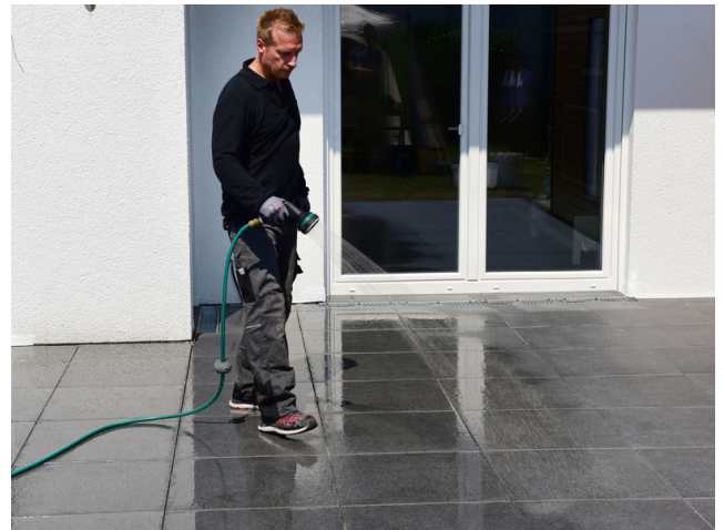
Vor der Verfugung muss die Fläche satt vorgemischt und feucht gehalten werden.
