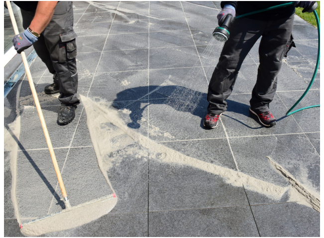
Die Fläche während des Fugens stets feucht halten.
