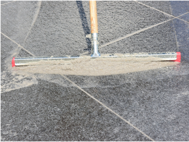
... und mittels Gummischieber in die Fuge einbringen.
