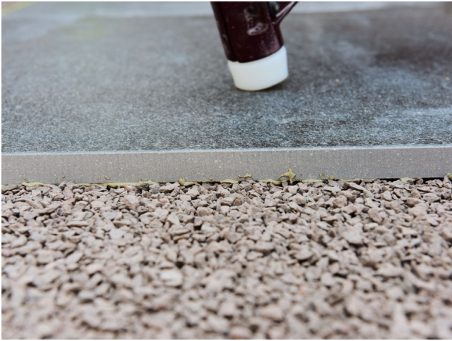
Die Platten einlegen und einklopfen.
