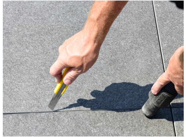
Die Fugen sind gründlich zu reinigen und von Rückständen zu befreien.
