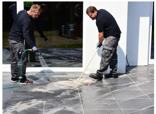
Material mit dem Wassersprühstrahl befeuchten, in eine geschmeidige Konsistenz bringen...
