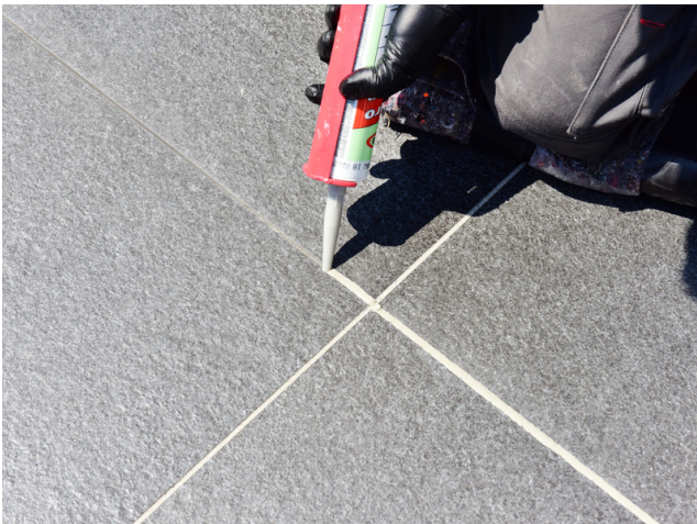
Anschluss- und Bewegungsfugen einbringen.
