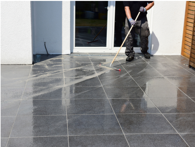
Überschüssigen Fugenmörtel abtragen ...
