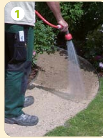
1 Schottertragschicht anfeuchten
