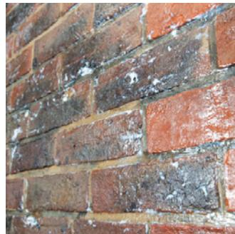
Watco Wasserabweisende Aussenbeschichtung beginnt 15 - 20 Minuten nach der Auftragung, ins Mauerwerk einzudringen. Sie widersteht leichtem Regen nach zwei Stunden.
