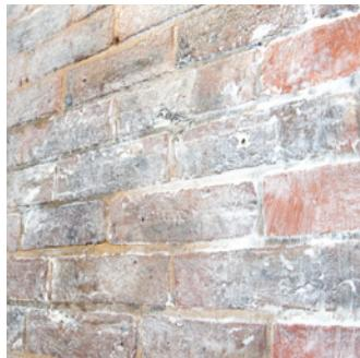
Watco Wasserabweisende Aussenbeschichtung ist direkt nach der Auftragung weiß, so dass Sie ungestrichene Bereiche leicht erkennen können.
