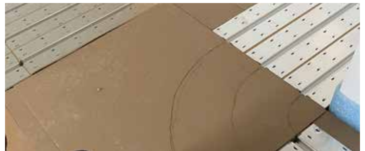
1. Rohrkanäle anzeichnen
