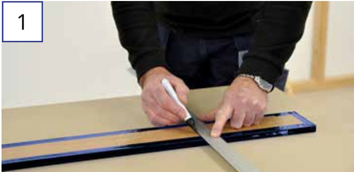
1 SCHNITTLINIE ABMESSEN & ANZEICHNEN
