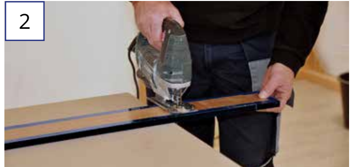
2 ENTKOPPLUNGSTREIFEN ZUSCHNEIDEN Handkreissäge mit Widiablatt & Absaugung Stichsäge mit Sägeblatt Holz oder Metall, Cuttermesser
