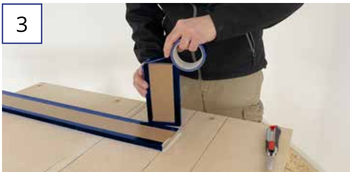
3 ENTKOPPLUNGSTREIFEN ABKLEBEN Schnittkante ausschließlich mit Wolf Tape abkleben. Das Wolf PhoneStrip Tape mind. 2 cm an den Ecken überstehen lassen.
