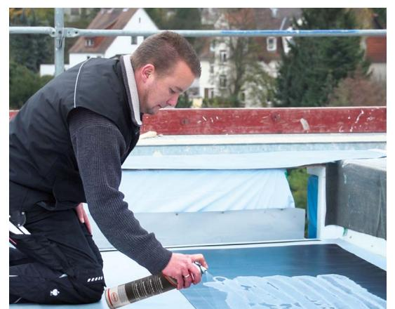
Sprühkleber beidseitig aufbringen, ablüften lassen („Fingerprobe“) und anschließend die Klebeflächen aufeinanderlegen und fest andrücken.
