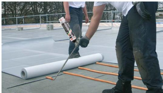
Zur Erzielung einer ausreichenden Klebverbindung zum Untergrund ist je Meter Bahnenbreite ein gleichmäßiger, mind. 3-streifiger Kleber-auftrag mit ca. 3 cm Durchmesser erforderlich.
