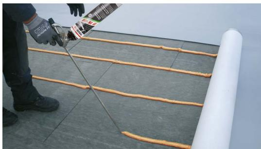
EF TK 400 kann deutlich schneller als herkömmliche, flüssige PU-Klebstoffe mittels Schaumpistole aufgetragen werden. Das bietet vor allem bei niedrigen Temperaturen einen großen Zeitvorteil.
