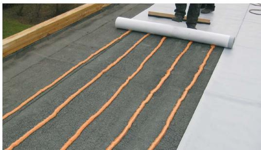
Anschließend wird die vlieskaschierte Dachbahn in den frisch aufgebrachten Schaum eingerollt und mit einem weichen Besen kräftig angedrückt. Bei eventuellem Nachschäumen des Klebstoffs Dachbahn nochmals nachdrücken.
